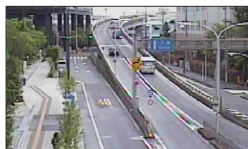
道路照明器具による遮蔽
