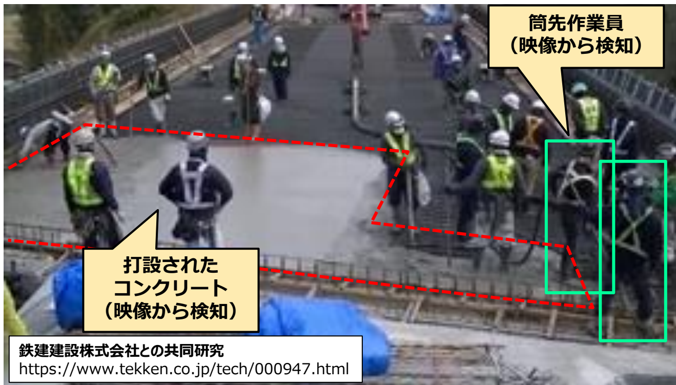
コンクリート打設の様子（橋の工事）
